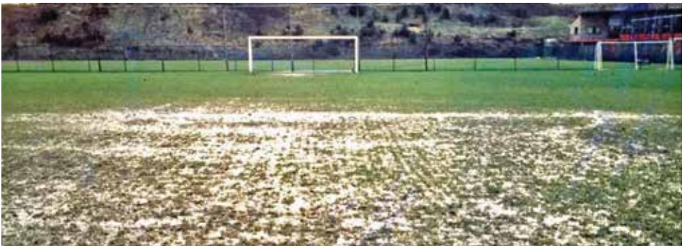
Afbeelding 3: Wateroverlast op een grassportveld in Den Haag door de aanwezigheid van een dichtere, humeuze, kleiige bovenlaag op een minder dichte kleiarme duinzandondergrond (Dekker en Van der Knaap, 1986)
